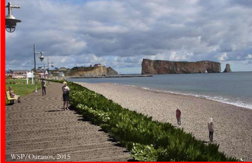
1. Recharge de galets
