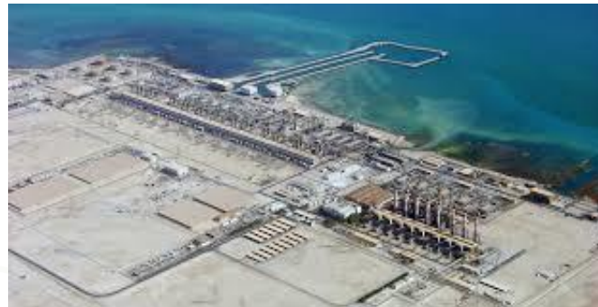
Station de Dessalement de Laayoune
