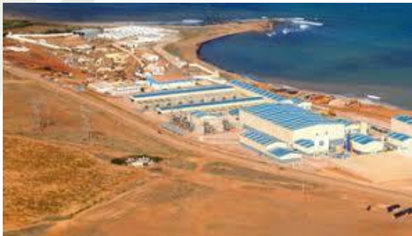
Station de Dessalement d'Agadir (en cours de réalisation)
